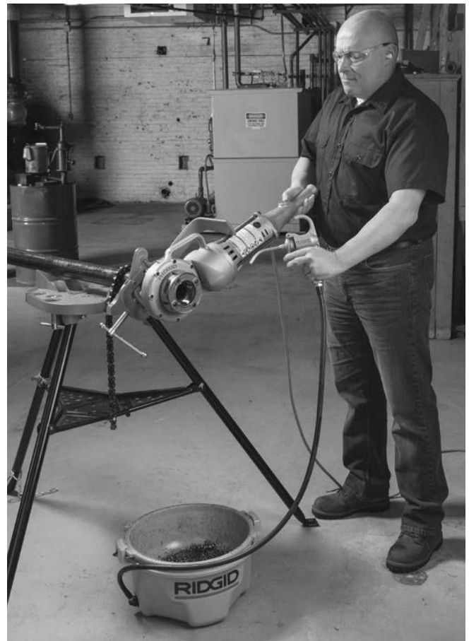
Figur 9 – Gjenging av rør
