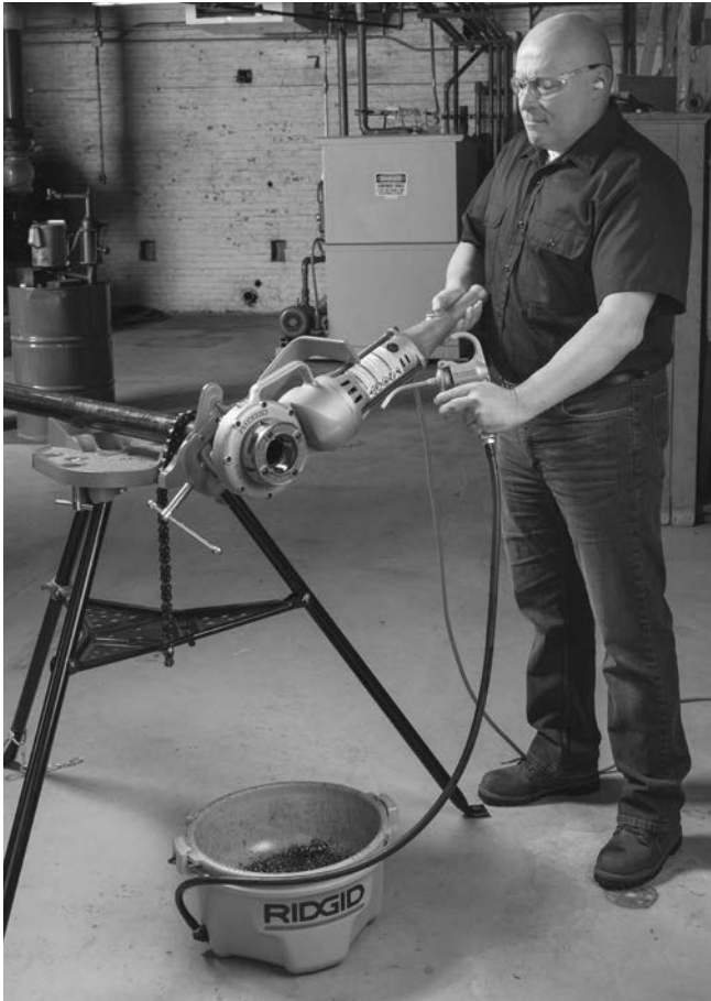
Abbildung 9 – Gewindeschneiden in Rohr
